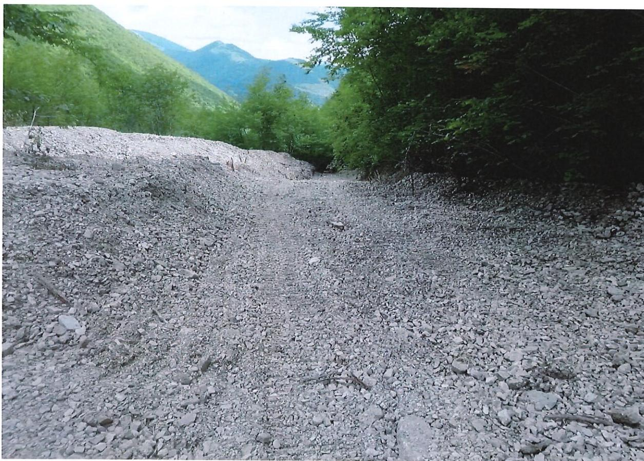
Riapertura dei fossi e ricreazione della superficie di scorrimento dell'alveo con spostamento di enormi quantità di materiale con ricreazione zone d'argine
